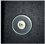
Système arrêt de porte par aimant
